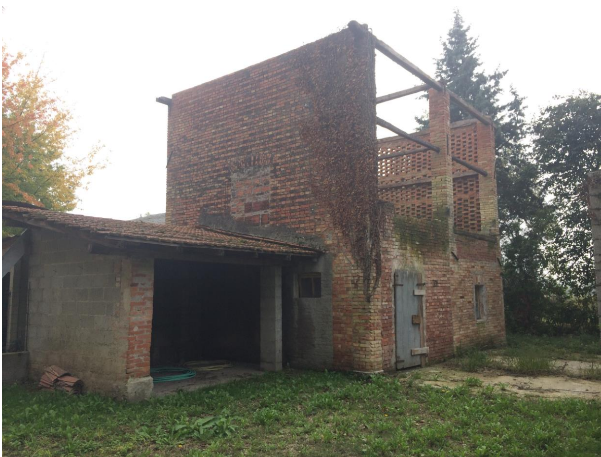
5. GLI EDIFICI OGGETTO DI DEMOLIZIONE: IL FABBRICATO IN LATERIZIO (DEPOSITO ATTREZZI AGRICOLI E GRANAIO) E IL VOLUME IN BLOCCHI MISTI
